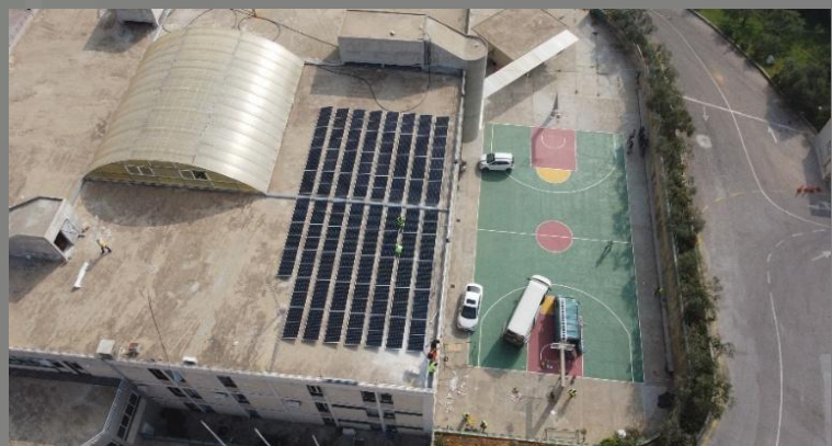
Beit El Baraka FORSA 2 1.868 MWp + 2.745 MWh
