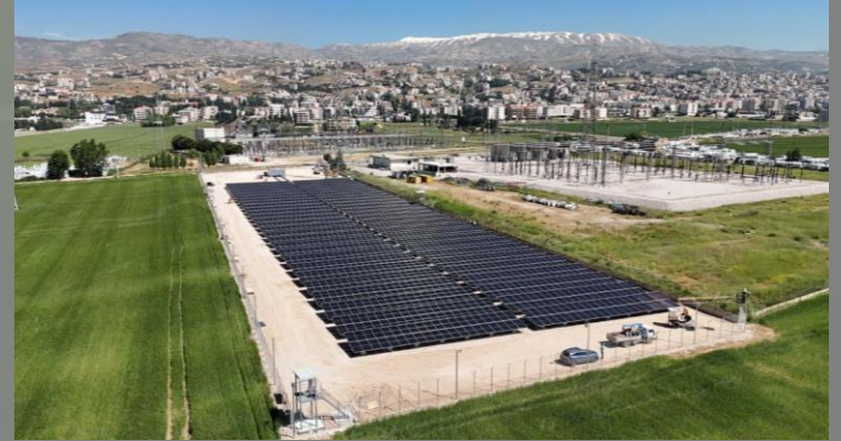
Electricité de Zahle 1.67 MWp
