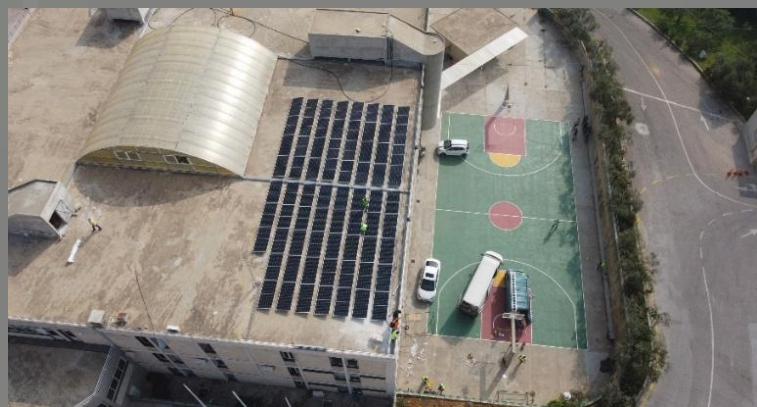
Beit El Baraka FORSA 2 1.868 MWp + 2.745 MWh
