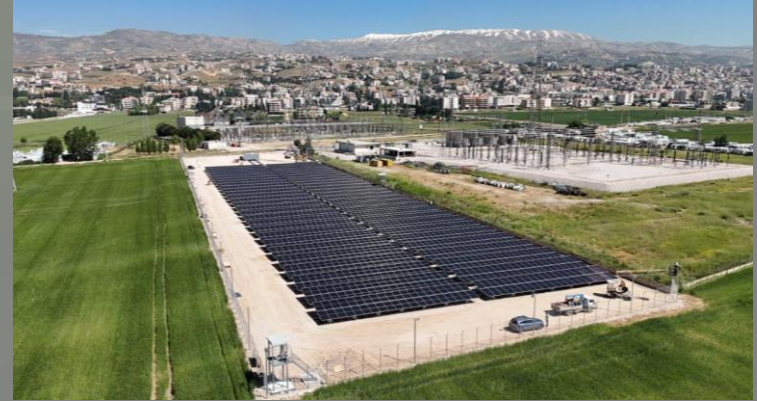
Electricité de Zahle 1.67 MWp
