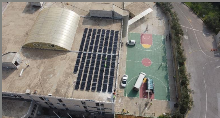
Beit El Baraka FORSA 2 1.868 MWp + 2.745 MWh
