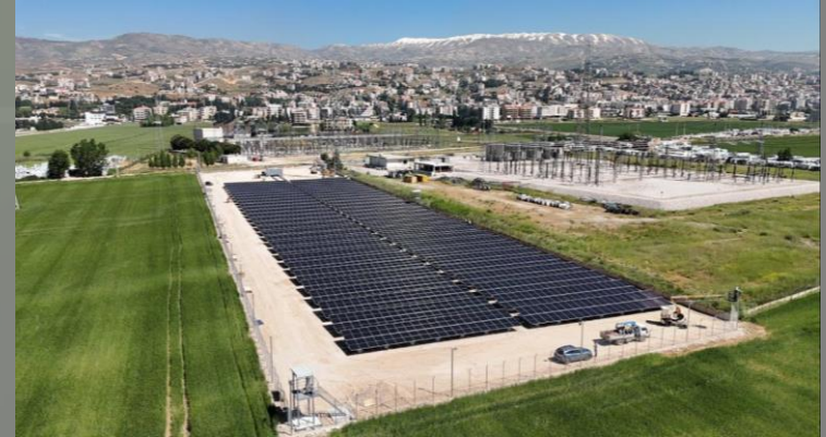
Electricité de Zahle 1.67 MWp
